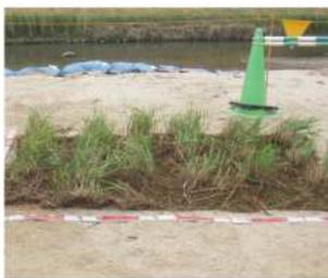
土壌を使用していないため、水切れが良く、軽量で施工性に優れています。また、取り扱いが簡便で根を傷めずに植栽できるため、短期間で良好に活着することができます。
