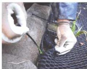
ヤシ繊維を基盤としたベストマンパレットでは、植物が定着するまでの一時的な固定のために、くさび形止杭が使用されていました。しかし、合成樹脂基盤ベストマンパレットは基盤が分解しませんので、従来の杭による固定の他、ケーブルバインダーなどで基盤を強固に固定することができます。
