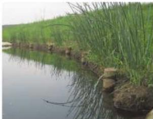
植栽済みベストマンロールは，一般的に河岸や湖岸に設置されます。流水域への導入の場合は岸を保護するため水際に，また，湖沼への導入の場合は，やや沖に設置し波浪による浸食の影響を和らげます。設置後，土壌を堆積させるとともに，波の力を分散するための幅の広い植物群落帯の形成を促進させます。植えつけた植物が群落を形成し，効果的に浸食を防ぎます。
