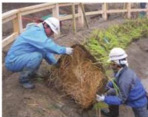
土壌を使用していないため、水切れが良く、軽量で施工性に優れています。取り扱いが容易で根を傷めずに植栽できるため、短期間で良好に活着します。
