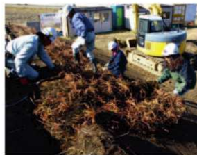
チガヤマットの設置状況
