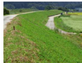
設置から1年が経過した 堤防法面の状況
