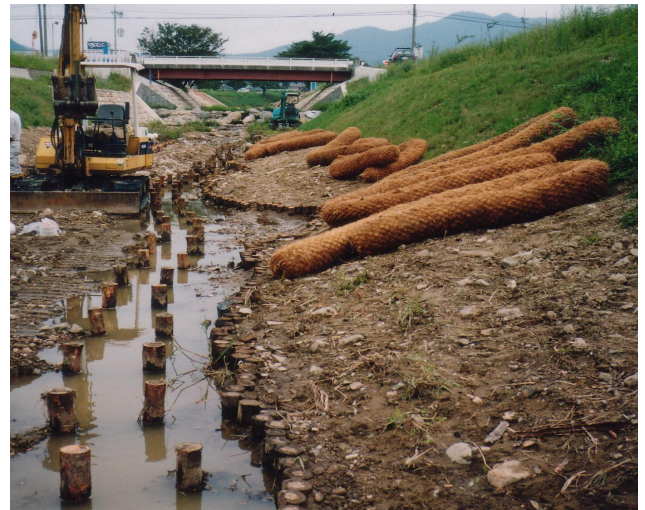
写真：木杭 両側打ちの状況
