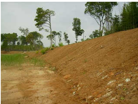
法面保護として敷設
