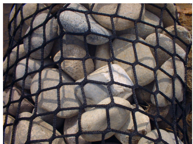
中詰材が玉石のチャンバーリベットメント
