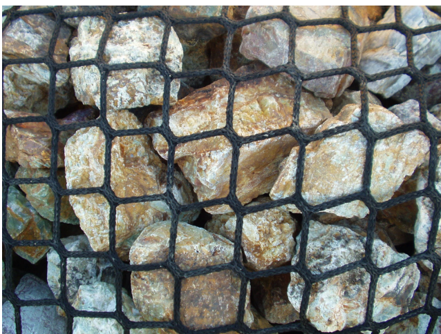
中詰材が割栗石のチャンバーリベットメント
