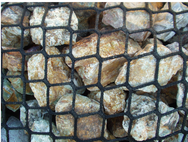
中詰材が割栗石のロックロール
