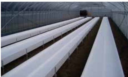
○栽培ベッドの設置
