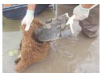
ヤシ繊維の袋には生分解性の内袋が格納されており、沈水植物の苗と現地発生土を充填する場所が分かれています。そのため、沈水植物を痛めずに現地発生土を充填することができます。
