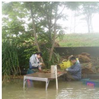
その地域に生育している沈水植物の移動を最小限にするため、沈水植物の植栽にあたっては可能な限りその地域に生育する植物を利用するとしています。現地に植物が多く生育している場合には、現場でマットに苗を植栽して、そのまま現場に設置することも可能です。しばらく育成させた苗よりも定着率は低くなる可能性はありますが、植栽時の苗の流出を抑制する上では沈水植物マットの使用は効果的です。一方、生育数が少ない場合には、ある一定期間育成して増やしてから現地に戻すこともできます。
