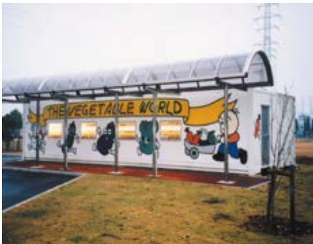
コンテナ式植物工場
