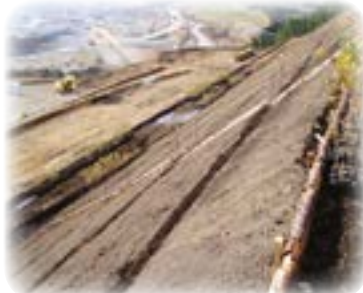
植栽基盤完了
