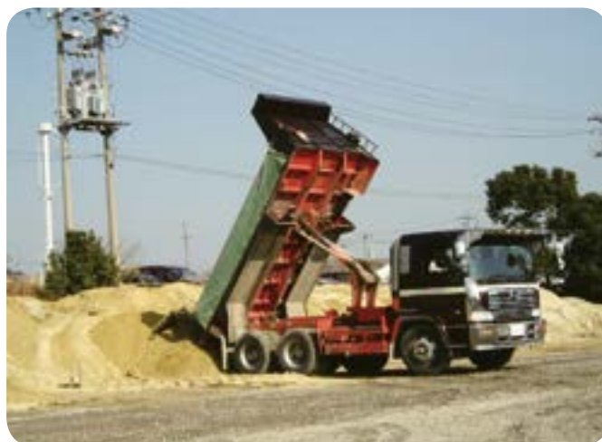
良質土、改良土投入、マウンド整形
