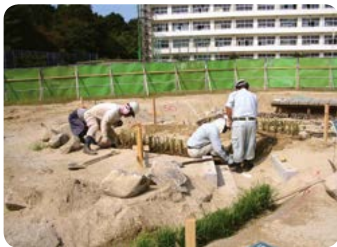
植栽済み植生ロール設置 護岸形成
