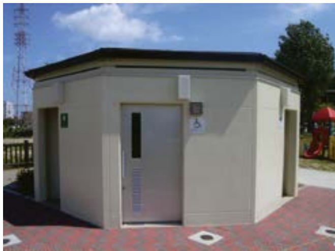
コーティング完成状況 愛知県日進市
