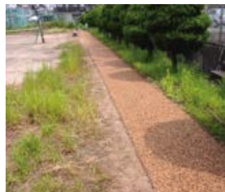
歩経路 敷設後
