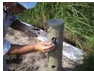
端部金物取付け
