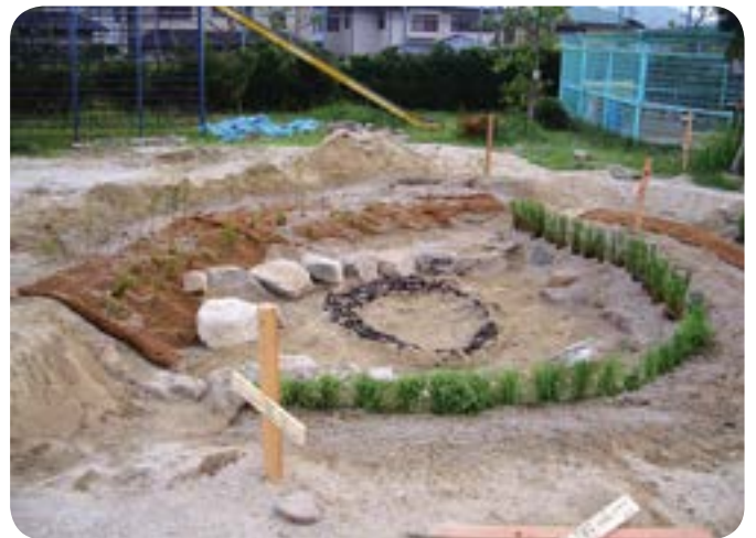
護岸形状完成
