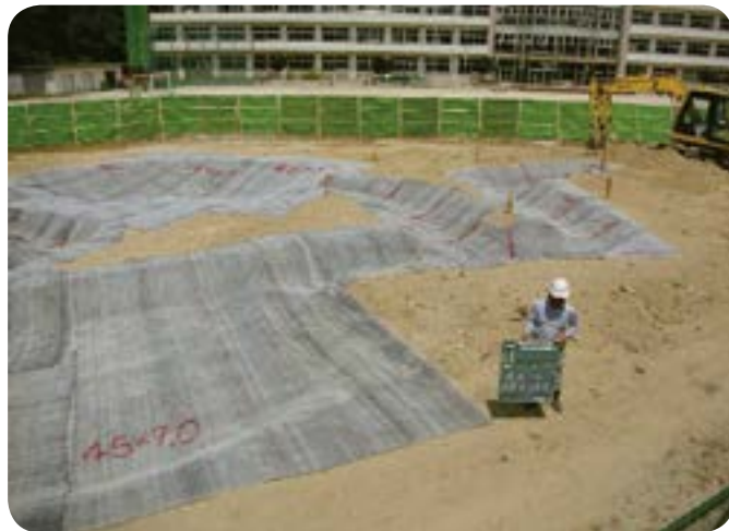
遮水シート設置
