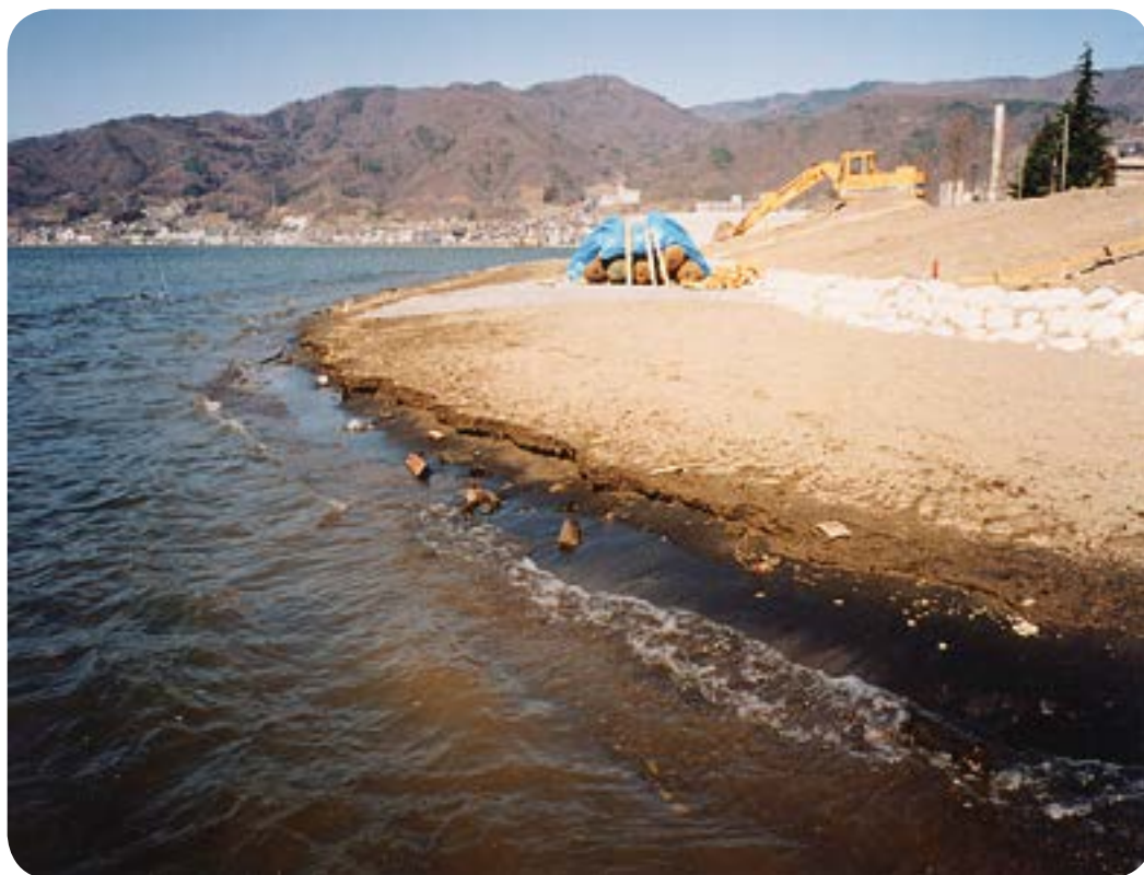
長野県 諏訪湖 施工前
