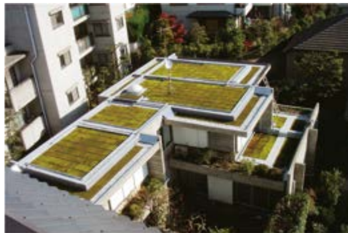
エスモス 屋上施工例
