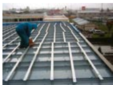
施工前 折板屋根
