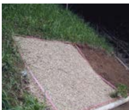
急斜面 敷設後
