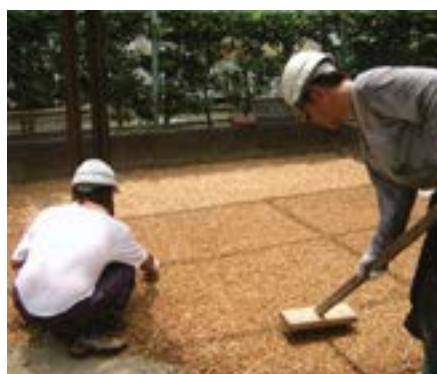
チップの敷き均し
