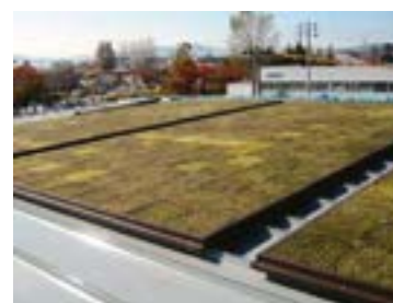
施工後 折板屋根
