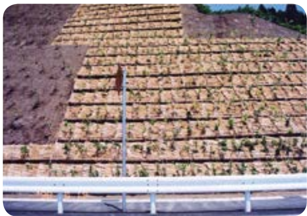
1998年5月 植栽工事直後 切土 1割勾配
