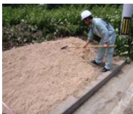
チップの敷き均し
