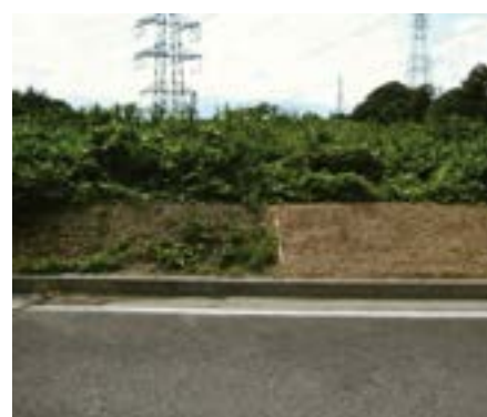
敷設後 1 ヶ月の状況
